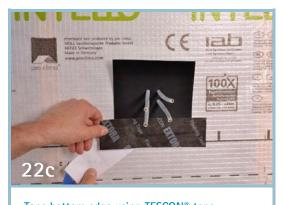
Tape bottom edge using TESCON® tape
